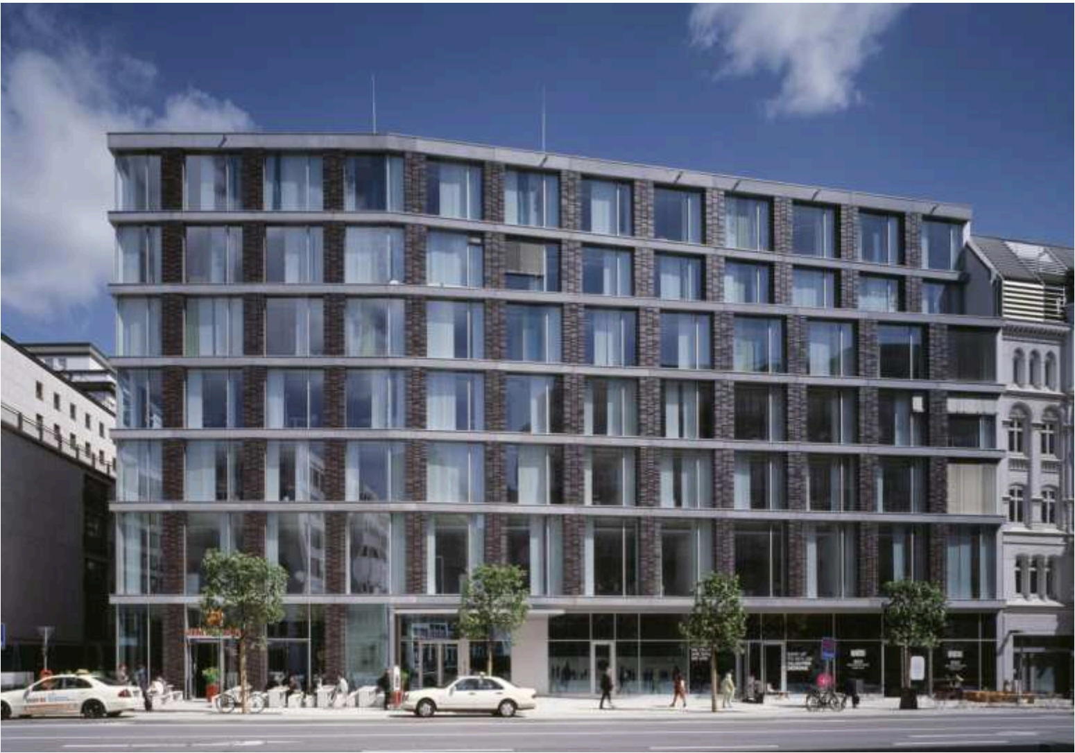
Metropolis Haus, Hamburg Fischötter Architekten, Hamburg
