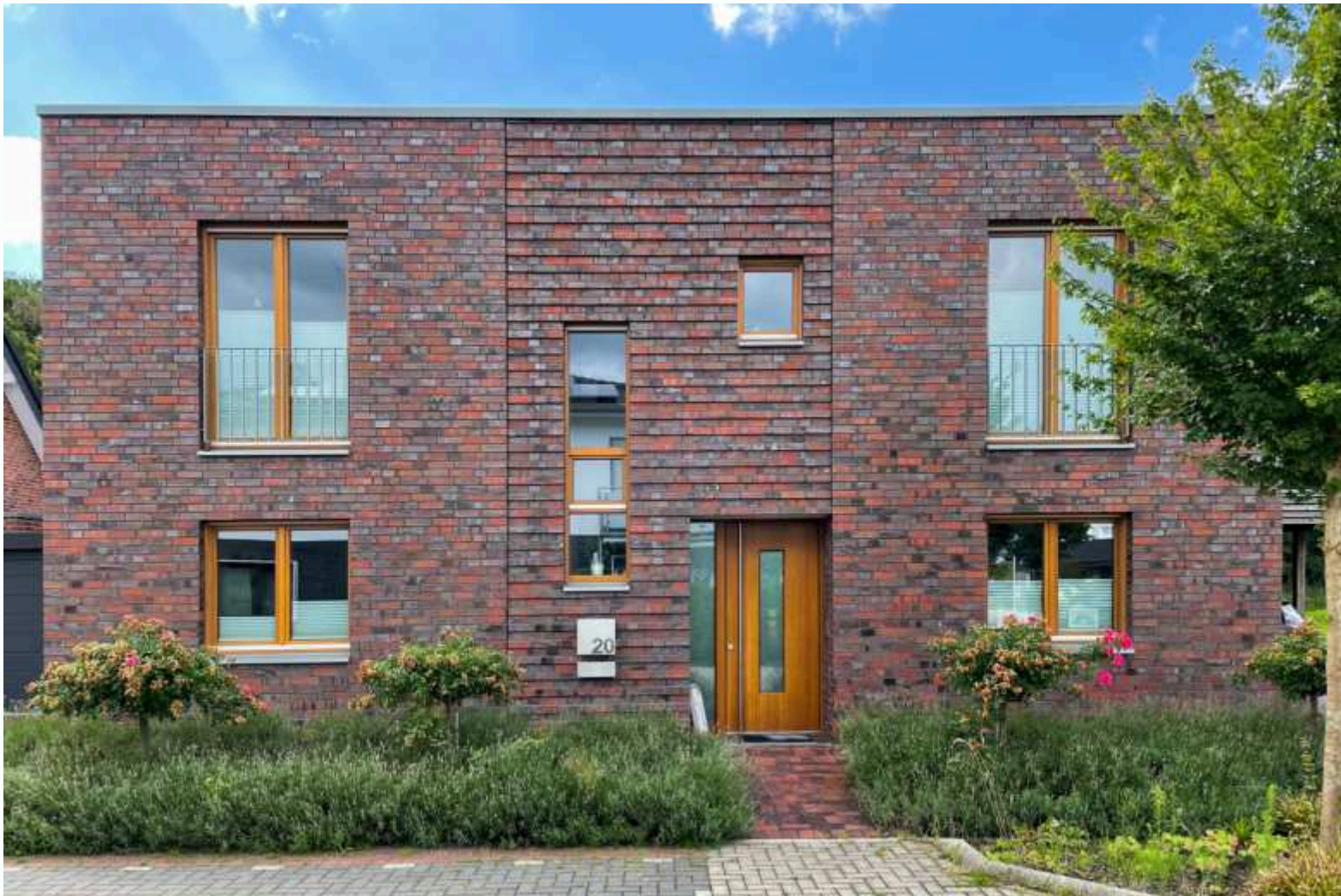
Haus G, Dorsten Figgenger Architekt, Dorsten
